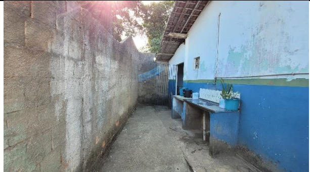
FOTO 18: Área para revitalização com acessibilidade, coberta e piso;
