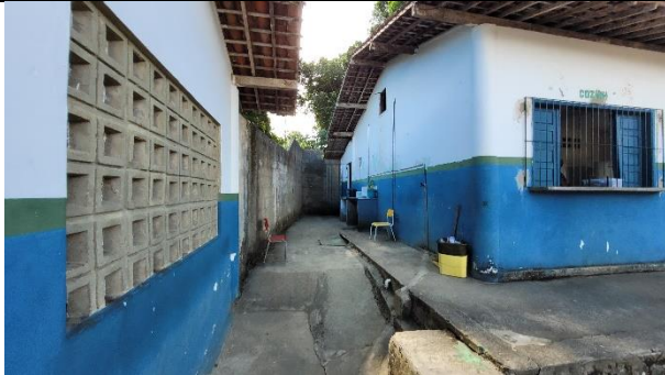
FOTO 17: Área para revitalização com acessibilidade, coberta e piso;
