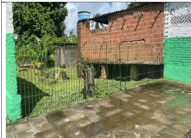
FOTO 5: Espaço para área de convivência;
