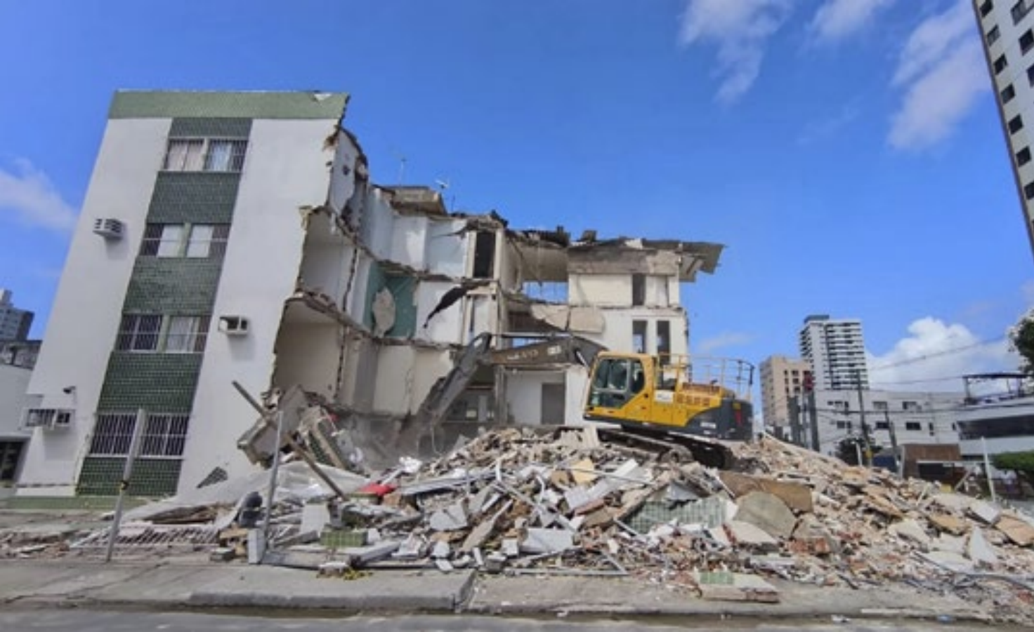
Demolição do edifício Kátia Melo, que desabou em Piedade, deve terminar na segunda-feira (12)
