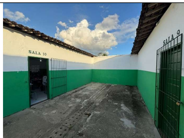
FOTO 8: Bloco existente que será reformado;
