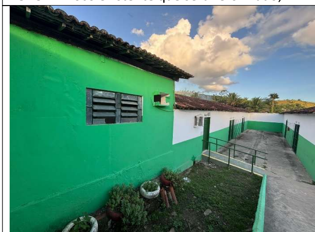
FOTO 9: Bloco existente que será reformado;
