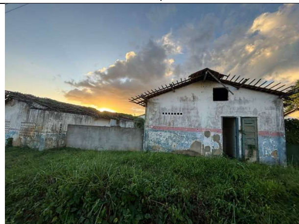
FOTO 12: Construção que vai ser demolida;
