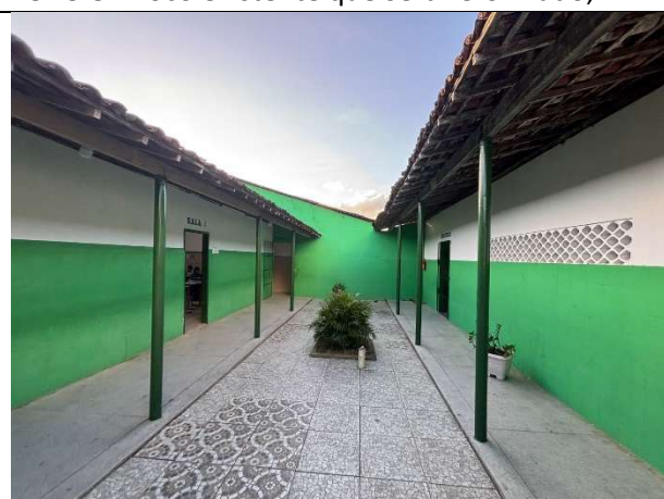
FOTO 10: Bloco existente que será reformado;
