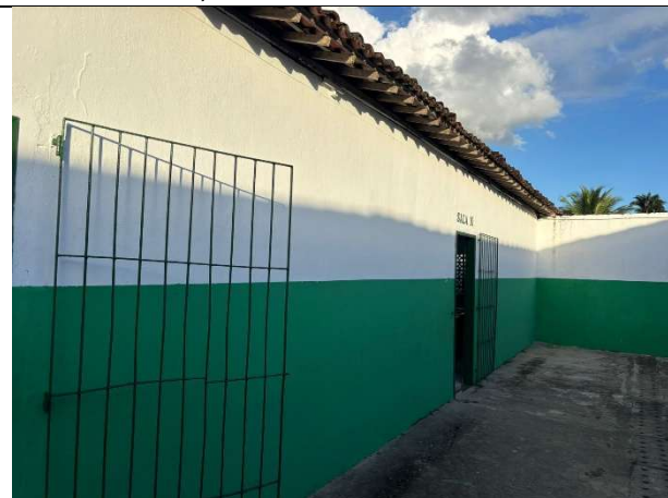
FOTO 5: Bloco existente que será reformado;
