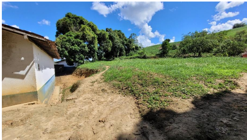
FOTO 09: Parte posterior da Escola Municipal Aluísio Sebastião – Distrito Pirangi;
